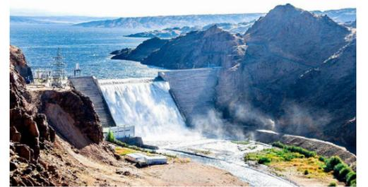
**ГЭС Тайшир** является зрелищным творением, созданным руками человека. Станция с плотиной высотой 130 метров построена на глубине каменитого ущелья, образуя бассейн объемом 930 кубических метров. Мощность ГЭС составляет 111МВт и может производить примерно 37 млн. кВт-час электроэнергии.
